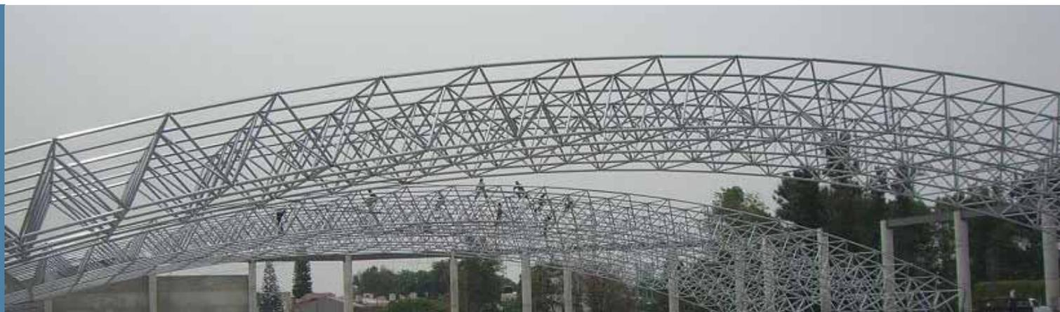
Trimetika diseña, fabrica, arma y monta estructuras tridimensionales de acero. El sistema TK está compuesto por dos piezas elementales: un nodo conector y barras de acero, que interactúan entre sí. Cumpliendo funciones de diseño y seguridad. Para llevar a cabo el diseño de cada estructura tridimensional se analizan y evalúan todas las posibilidades para crear diversas alternativas.
