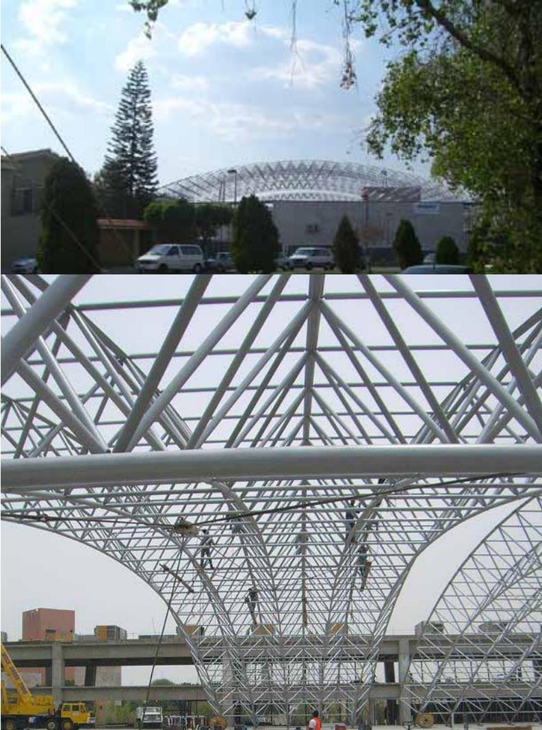
Toda estructura es 100% atornillable, por lo que el armado se ejecuta en la zona de la obra, la mayoría de las veces a nivel de tierra, salvo algunas excepciones en las que la unión de la estructura se ensambla a nivel final, si las condiciones de la obra lo exigen.
